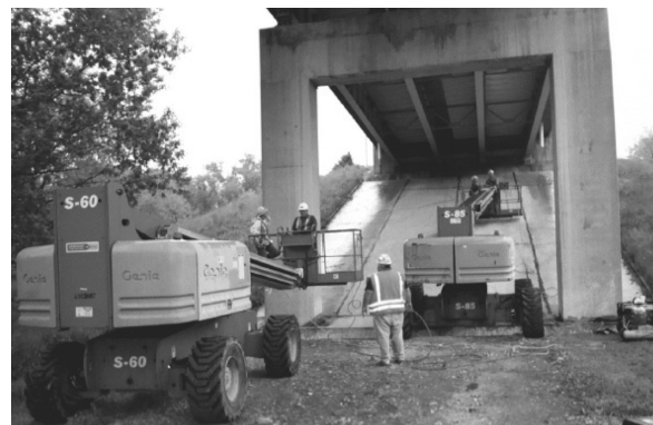
写真2 溶接橋梁への超音波ピーニング：UP処理の準備状況（2台のUPシステムとリフト）
