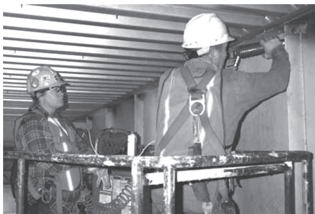
写真6 溶接橋の縦スティフナ溶接単部へのUP処理状況
