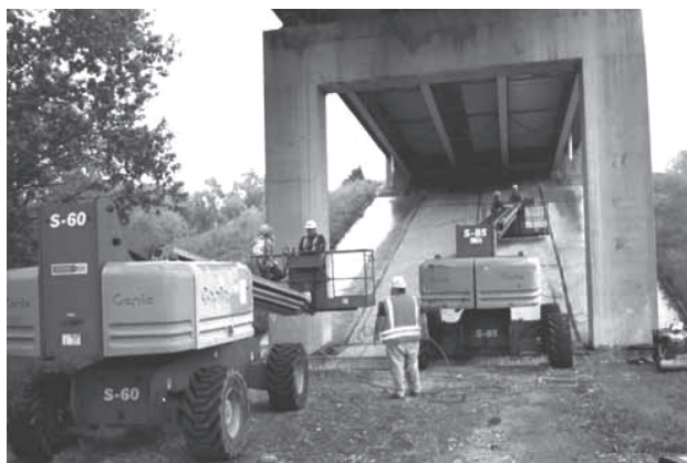
写真5 溶接橋梁へのUP処理準備状況（2つのUPシステムとリフト）
