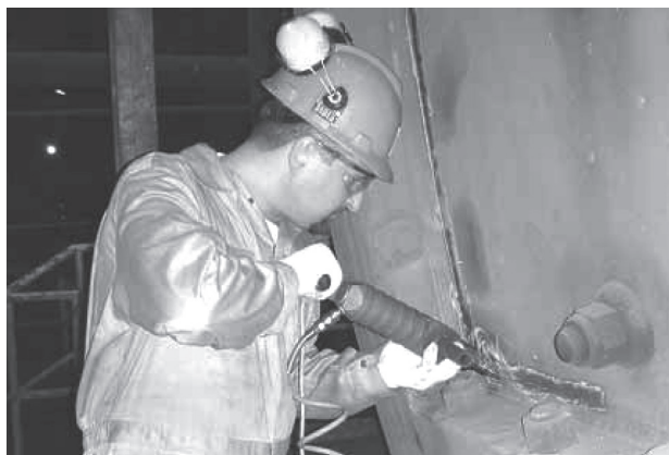
写真4 破砕機の溶接継手の疲労回復と補修溶接部へのUP適用状況
