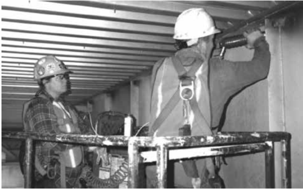
図22 溶接橋の縦スティフナ溶接端部へのUP処理状況
